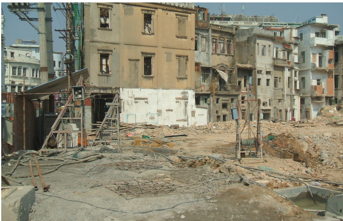
图为拆迁工地
